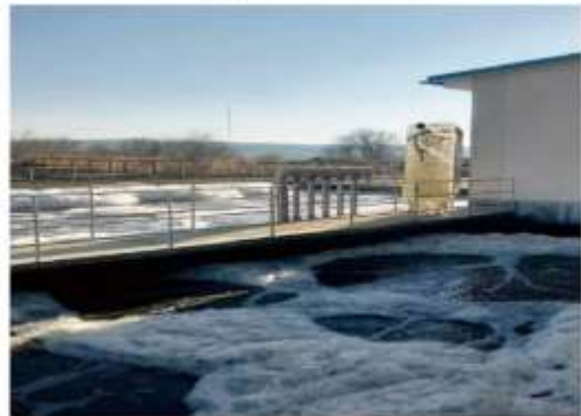
Instalația pilot cuplată la sistemul de schimb de energie termică
