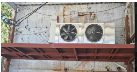
Instalație frigorifică cu 2 compresoare
