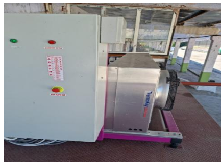
Instalație frigorifică cu 2 compresoare
